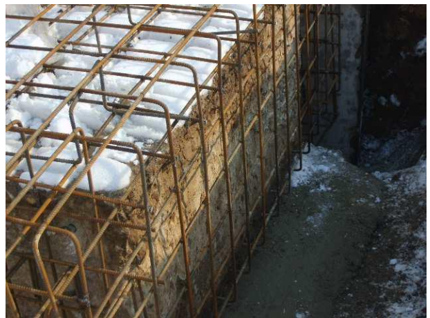
betonacél szerelés
