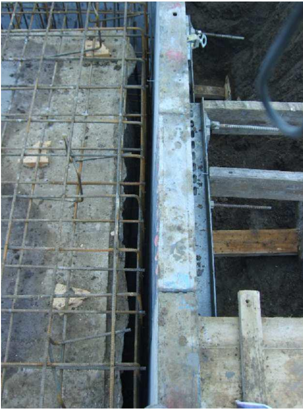
betonozás előtt alulról
