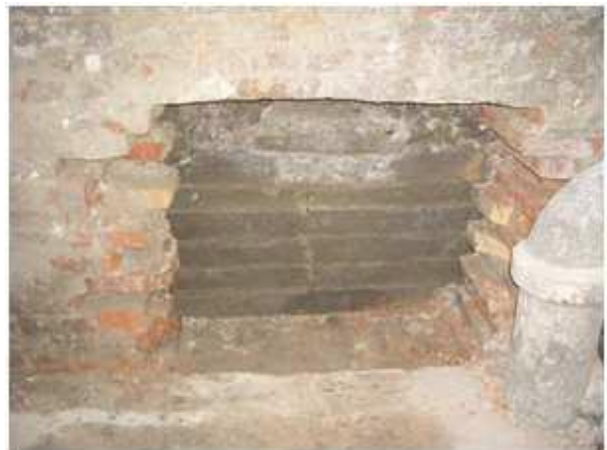
betonozva, kiszaluzva
