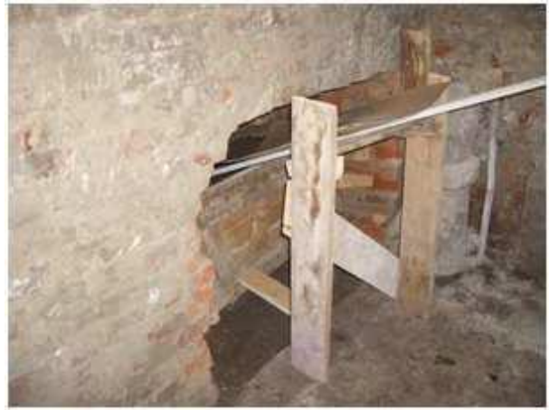
betonozás közbeni állapot
