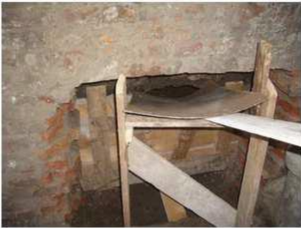
betonozás közbeni állapot
