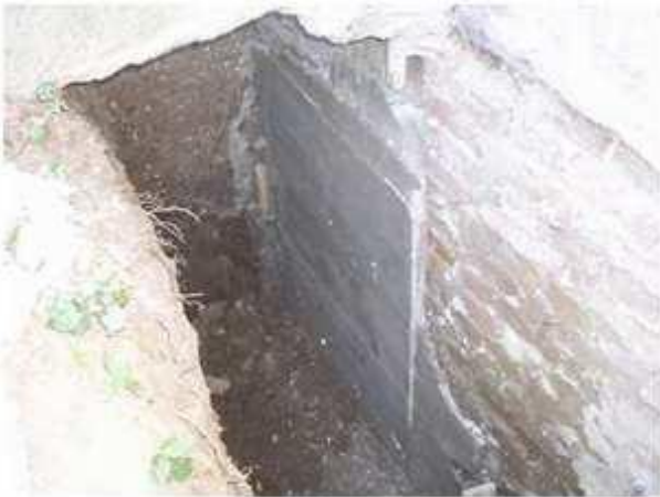
betonozás utáni állapot
