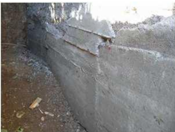
betonozás utáni állapot
